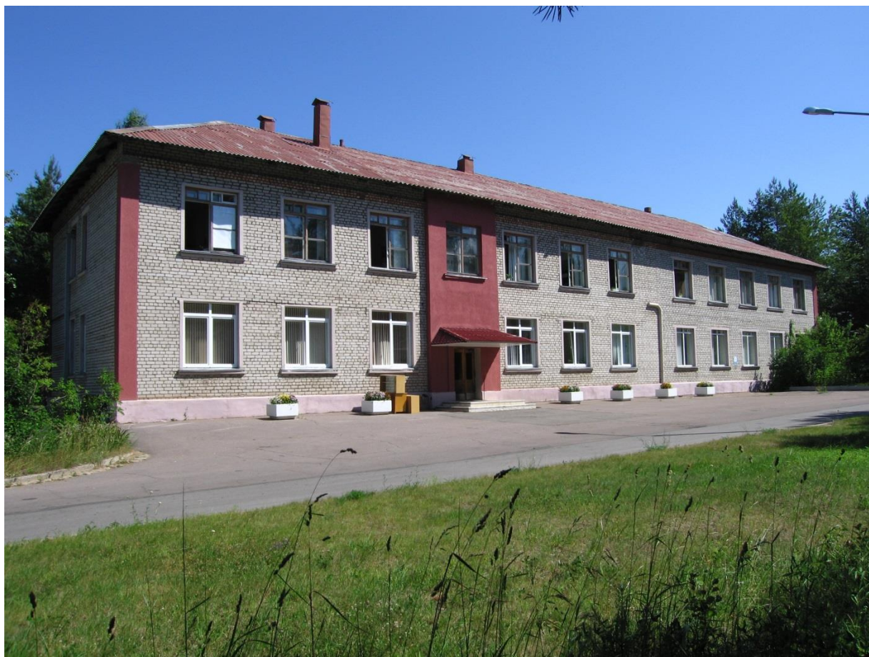
Рисунок 8 - Здание управления Ленинградского отделения
