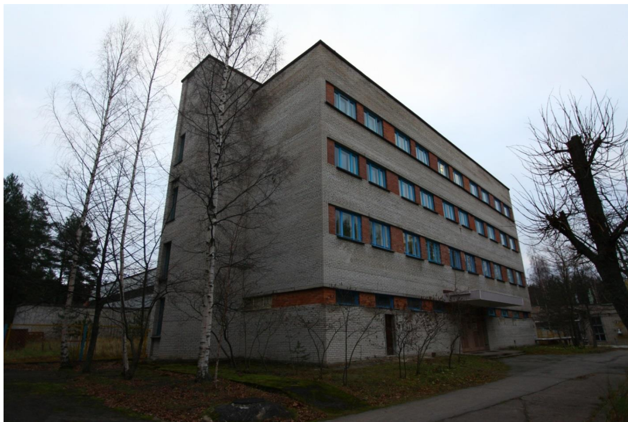
Рисунок 26 - Производственное здание Ленинградского отделения
