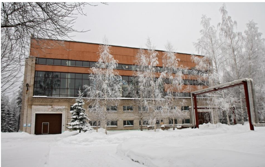
Рисунок 15 – Производственное здание Ленинградского отделения
