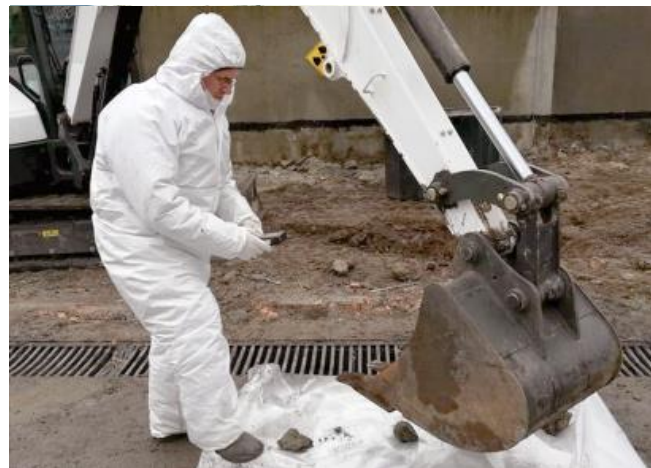
Рисунок 18 - Радиационный контроль – Радиационный контроль окружающей среды
