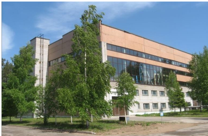
Рисунок 23 – Производственное здание Ленинградского отделения СЗТО ФГУП «ФЭО»
