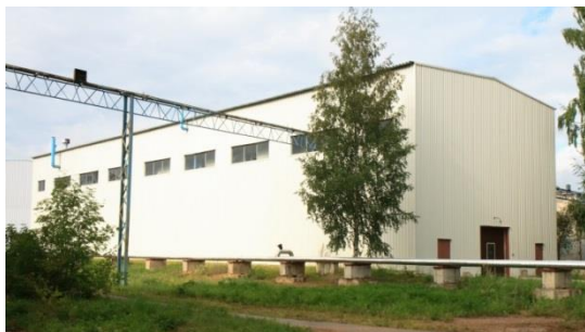
Рисунок 27 - Производственное здание Ленинградского отделения
