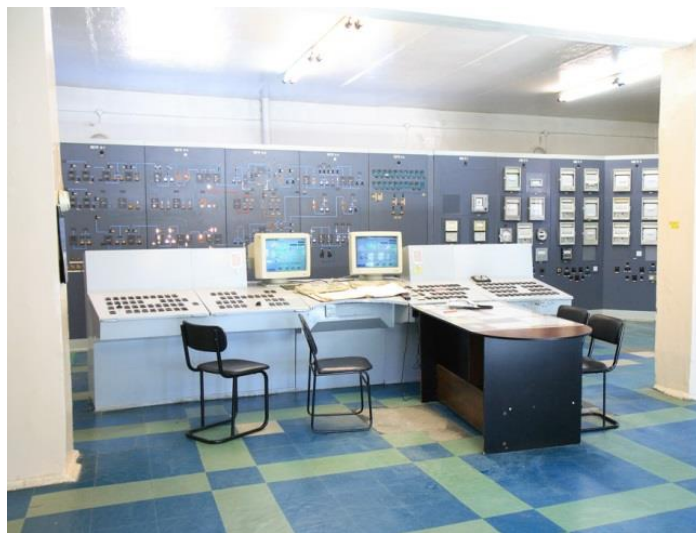
Рисунок 4 - Щитовая установки сжигания
